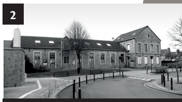
2 MAISON DE QUARTIER CENTRE
